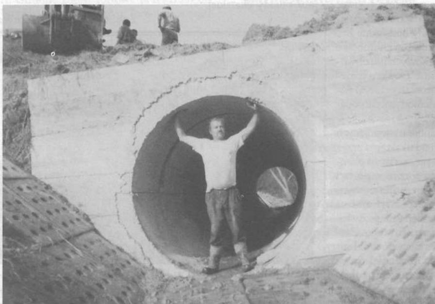
Prace przy odbudowie drogi i mostu zniszczonego podczas powodzi w dniu 23.07.2001 r.
