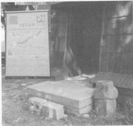
Lipiec 2002r. – Remont trwa.
